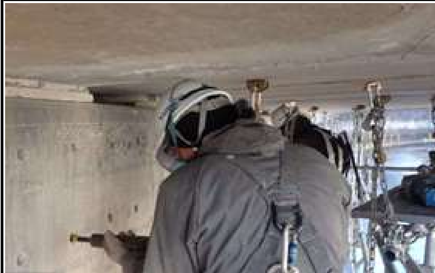
RC縁端拡幅工
