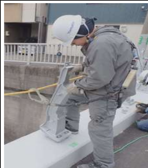
橋梁用車両防護柵取替工
