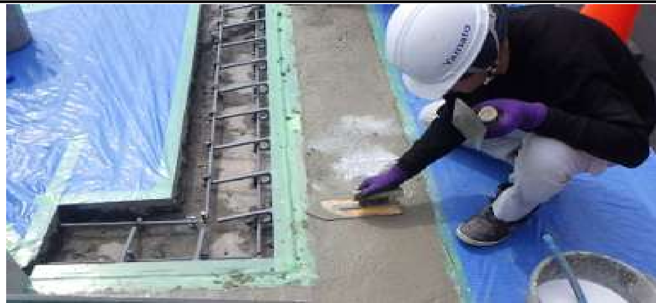
伸縮継手装置設置工
